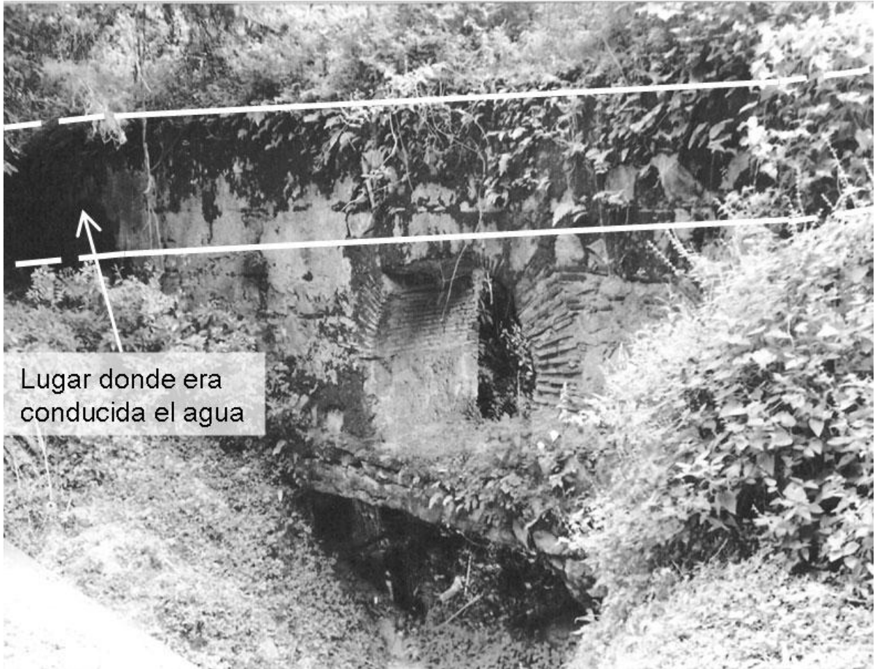
Figura 10 Detalle de un sector del acueducto Las Cañas
