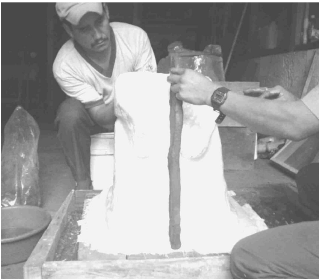
Figura 4 Separador de barro sobre el molde del Monumento 99, para elaborar un contra molde de dos piezas (Foto J. Crasborn 2006)
