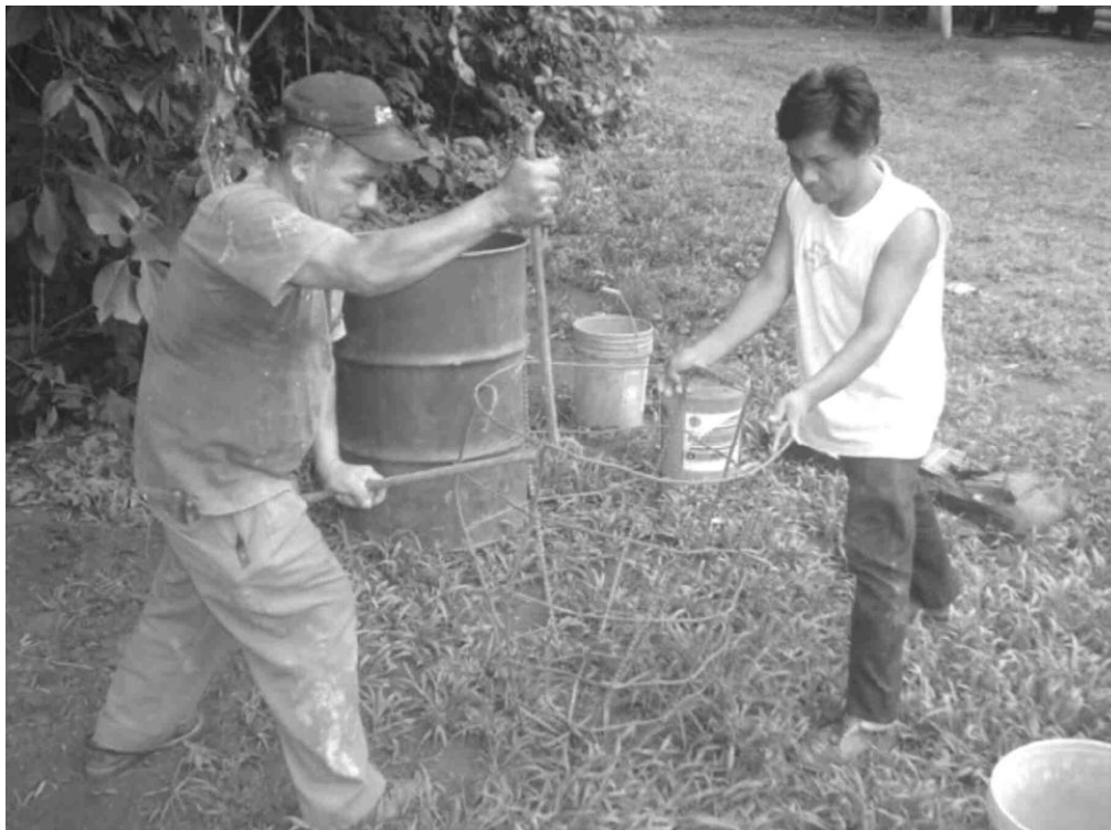
Figura 6 Elaboración de armazón de hierro para la réplica del Monumento 93. (Foto J. Crasborn 2006)
